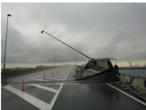
台風15号による南本牧ふ頭の橋「はま道路」・金沢区福浦の護岸損壊
